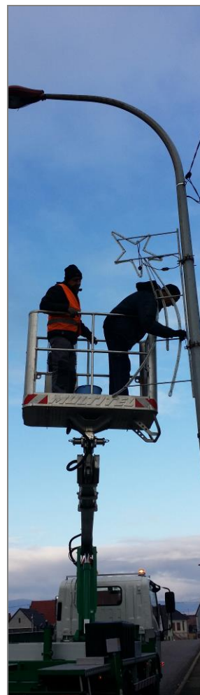
Mise en place des illuminations 19/11/19 - Photo NBS/RT
