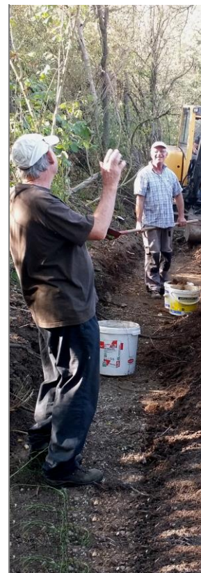
Travaux de curage du petit canal Août 2018 - Photo NBS/RT
