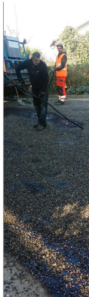
Pose d'enrobés bicouches par la société Tradec Sept. 2018 - Photo NS/RT
