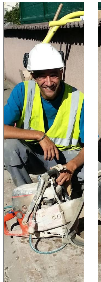
Raccordement du 1 er particulier au réseau de gaz naturel 07/09/2016 - Photo NBS/RT
